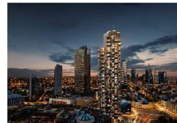
Huoneistokohtainen lämmitys- ja viilennysjärjestelmä Saksan korkeimpaan asuinrakennukseen: Grand Tower, Frankfurt, Saksa
